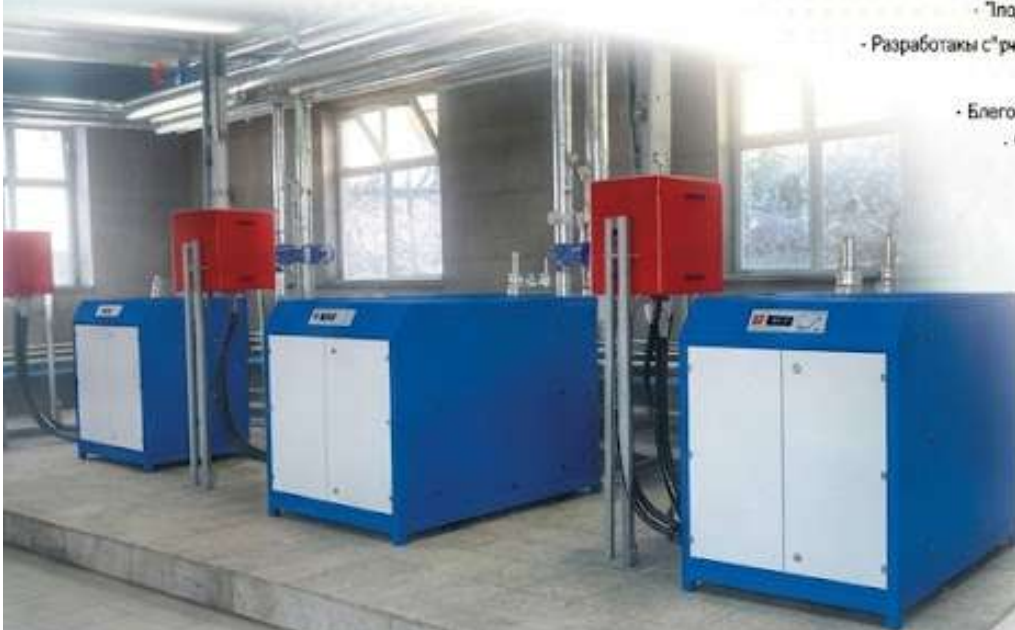
4.000 kW Elektrikli Kalorifer Kazanı
